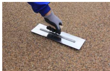
5. Уплотните материал с помощью металлической гладилки
