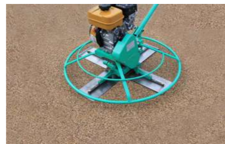
6. Уплотните материал с помощью затирочной лопастной машины
