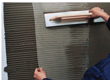
Устройство армирующего базового слоя
