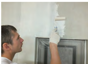
Грунтование армирующего базового слоя
