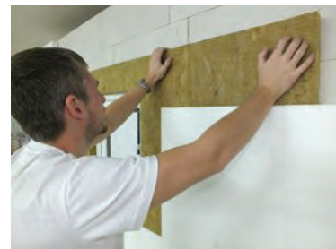
Монтаж противопожарных элементов
