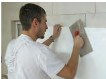
Установка теплоизоляционных плит
