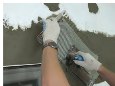
Выполнение дополнительного армирования
