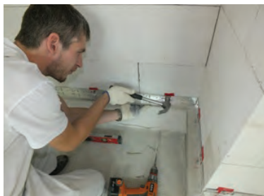
Установка цокольного профиля
