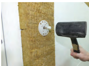
Механическое закрепление приклеенного утеплителя
