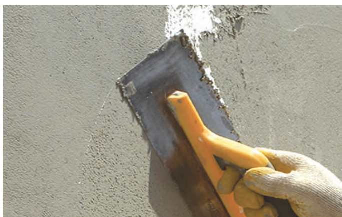
Нанесение базового армирующего слоя
