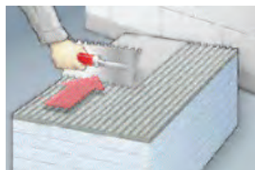
Гребенчатый способ нанесения
