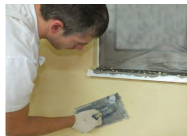
Устройство защитно-декоративного слоя
