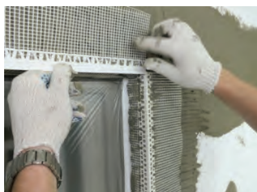
Установка фасадных профилей
